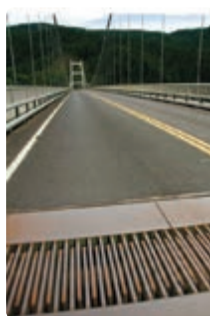
(ب) نمونه‌ای از بست‌های انبساطی
