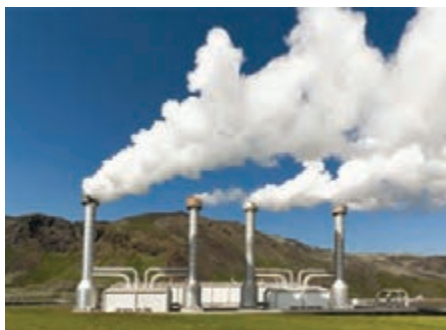
شکل ۱۱-۶- نیروگاه زمین گرمایی مشکین شهر- اردبیل
