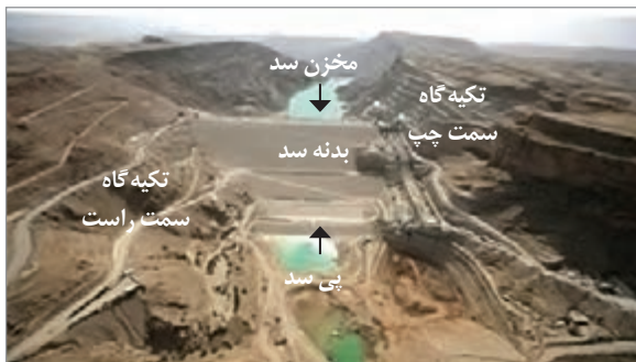
شکل ۴-۵- نمایی از بخش‌های مختلف یک سد
